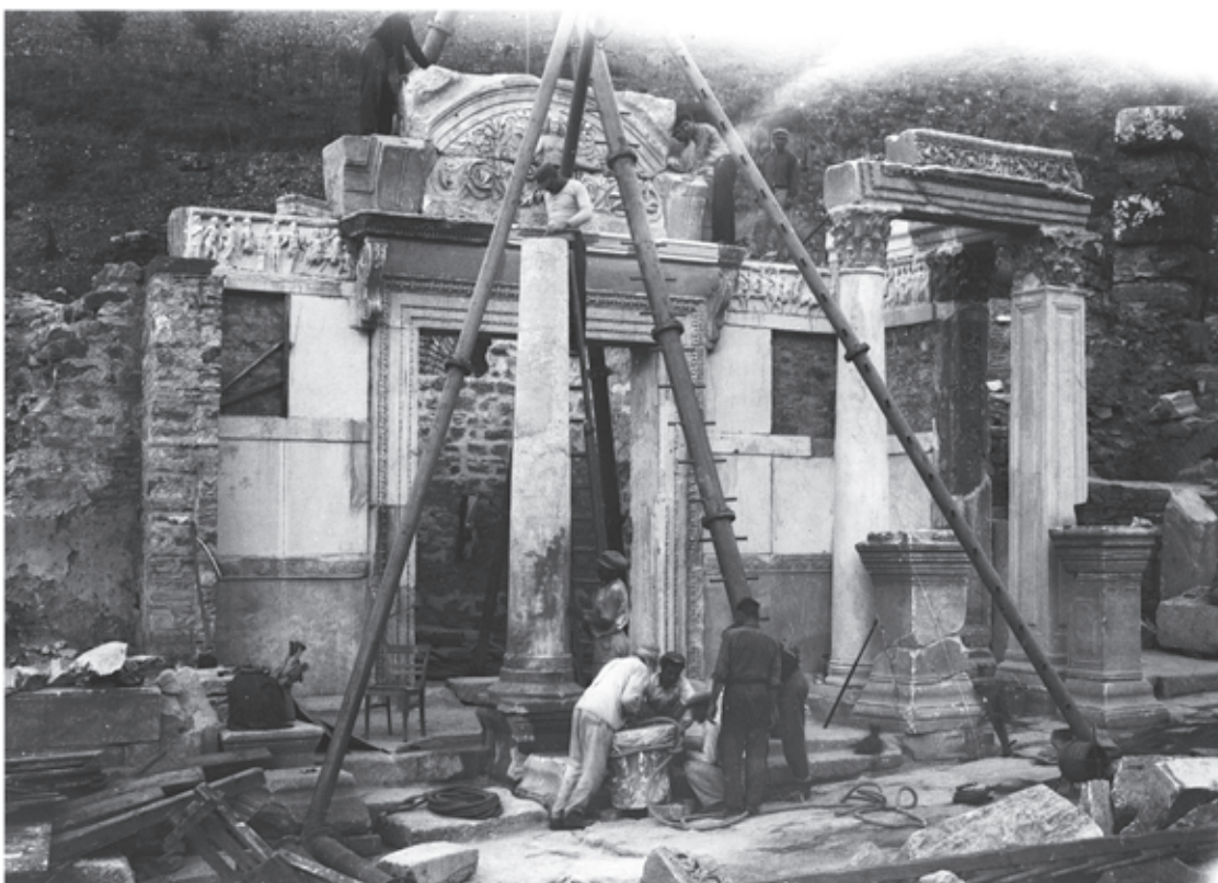
2 Versetzen des Säulenkapitells 018K und fertiggestellte Lünette
