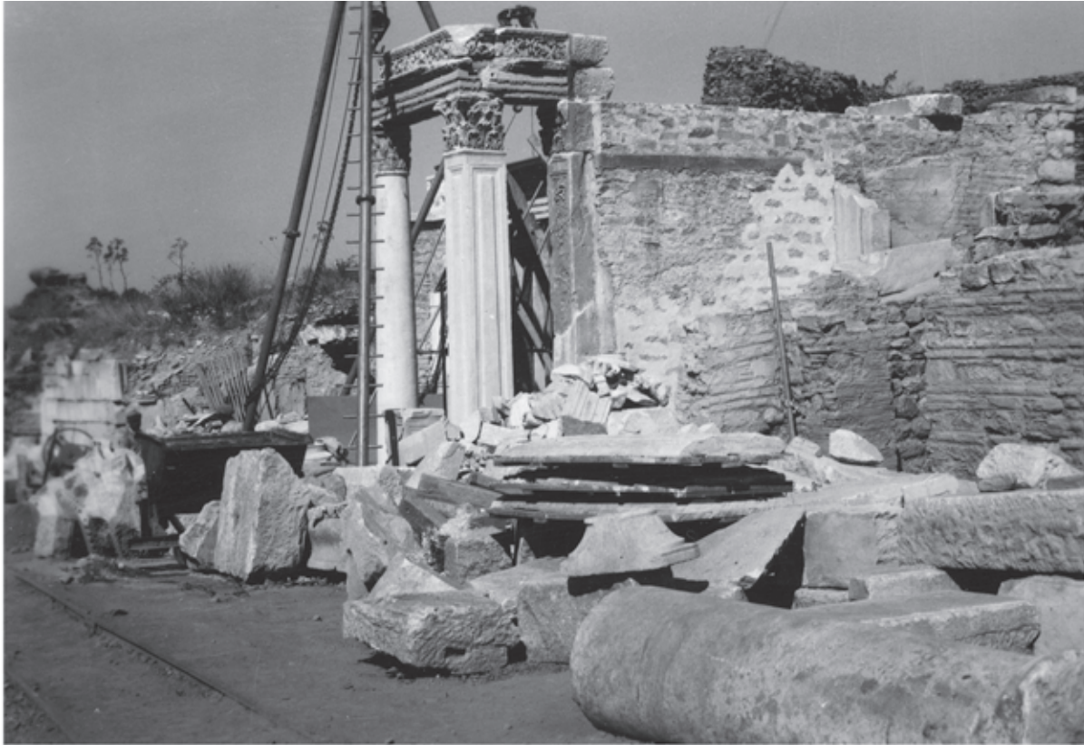
1 Wiederaufbau des ›Hadrianstempels‹, Zwischenzustand von 1957: Cella-Ostwand mit Antrag des Mauermörtels
