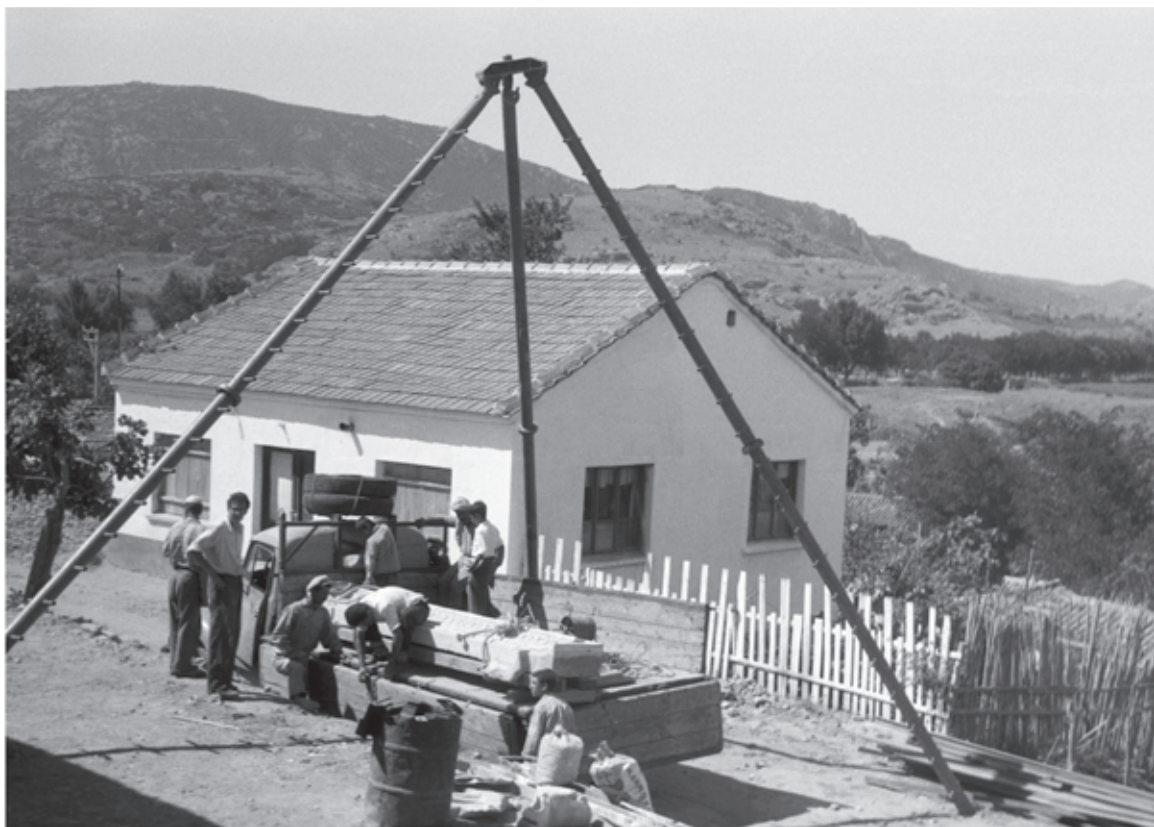
1 Der Türsturz zur Cella während der Anfertigung im Grabungshaus
