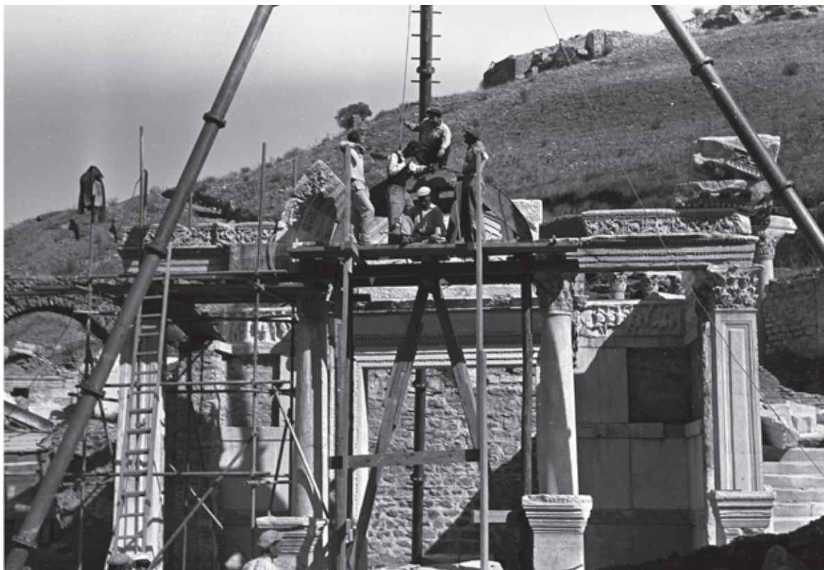
1 Errichtung des »syrischen Bogens« mittels eines Lehrgerüsts
