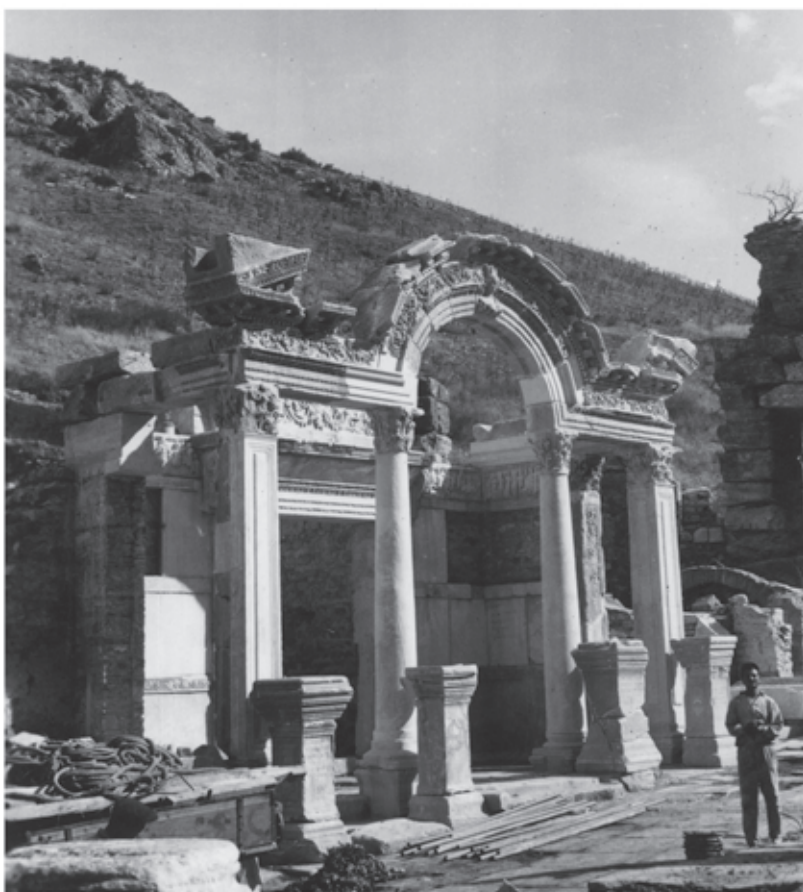
1 Versetzen der Gesimsblöcke am »syrischen Bogen«
