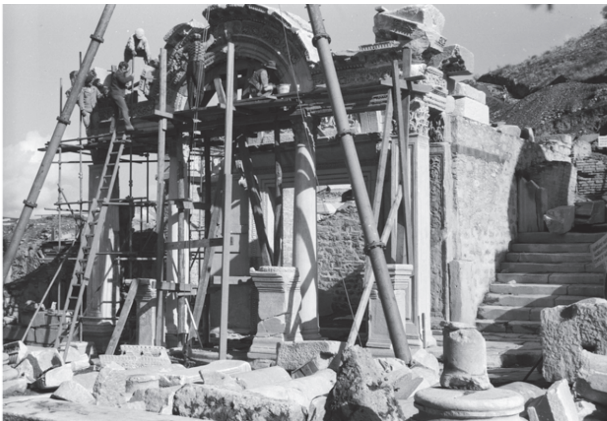
1 Versetzen der Gesimsblöcke am »syrischen Bogen«
