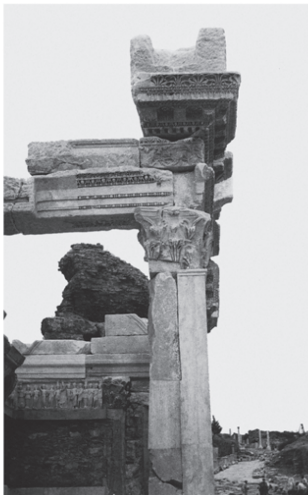
2 Der westliche Pfeiler 013Se mit den darüberliegenden Bauteilen nach der Fertigstellung im Jahr 1958
