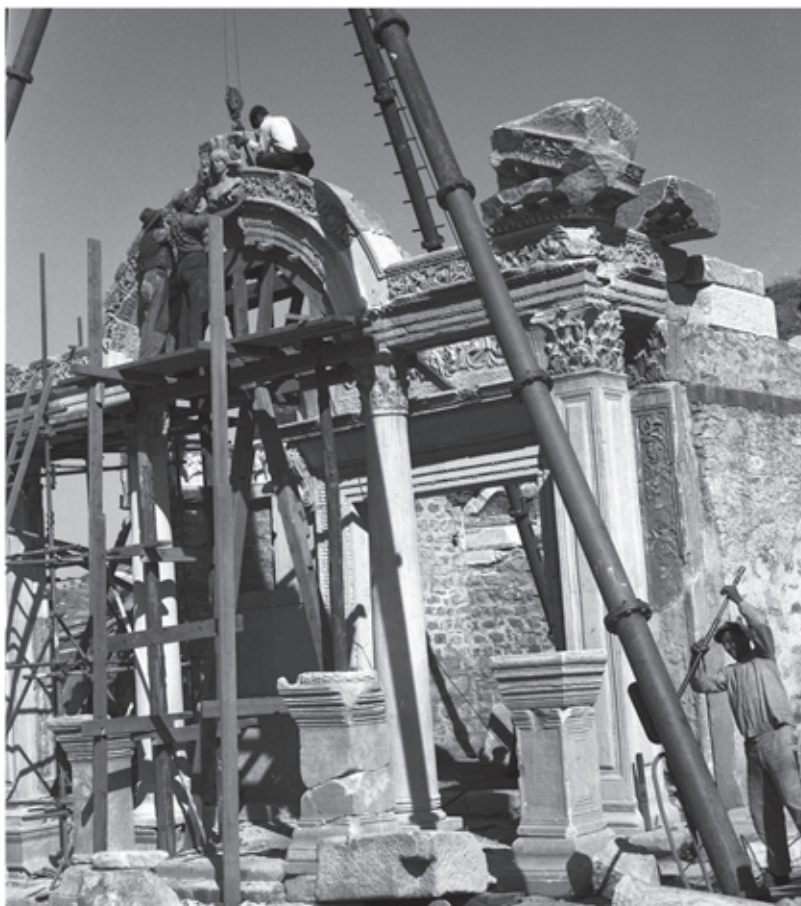
1 Errichtung des »syrischen Bogens« mittels eines Lehrgerüsts
