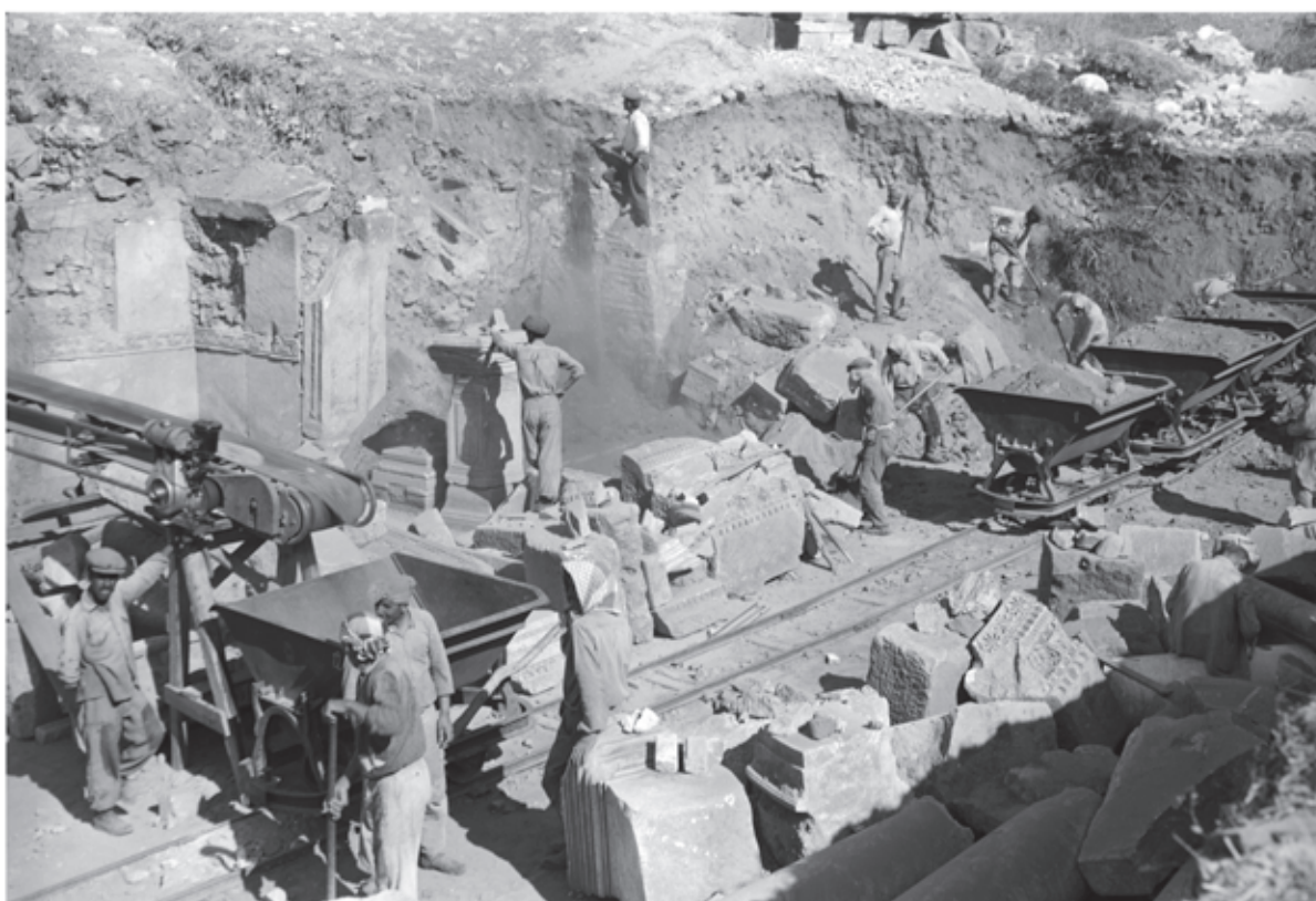
2 Der »Hadrianstempel« und der östlich anschließende Bereich während der Ausgrabung
