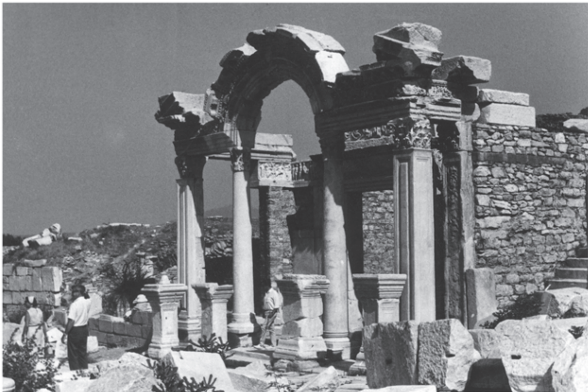
2 Wiederaufbau des ›Hadrianstempels‹, Endzustand von 1958: Mörtel an der Cella-Ostwand zurückgedrängt
